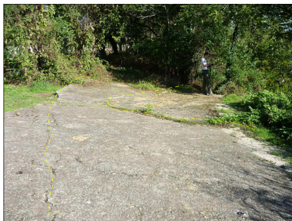
Figure 22 : Affaissements des berges du Tarn, en bordure du Cours Foucault, ayant entraîné des ruptures et des décalages de dalles [Source : IMS RN ]
