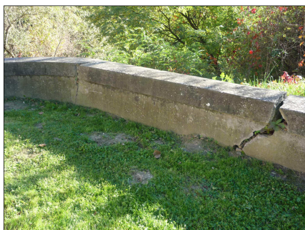
Figure 23 : Affaissements des berges du Tarn, en bordure du Cours Foucault, ayant entraîné des ruptures et des décalages de parapets [Source : IMS RN ]
