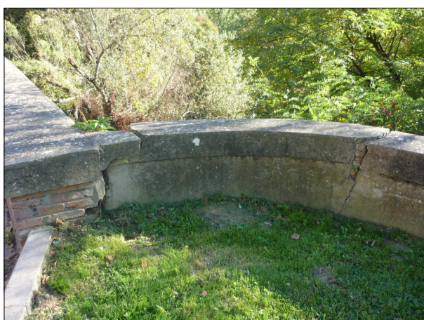
Figure 23 : Affaissements des berges du Tarn, en bordure du Cours Foucault, ayant entraîné des ruptures et des décalages de parapets [Source : IMS RN ]
