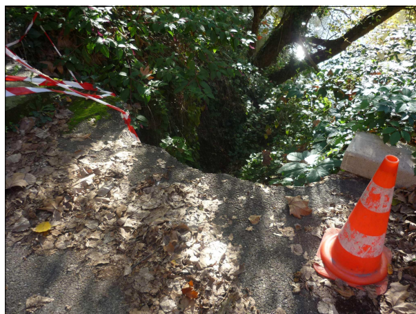
Figure 24 : Affaissements des berges du Tarn, en bordure du parking des berges, ayant provoqué le décalage du parapet (à gauche) et la disparition d'une partie de la chaussée (à droite) [Source : IMS RN ]
