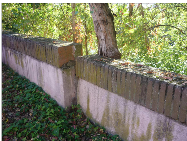
Figure 24 : Affaissements des berges du Tarn, en bordure du parking des berges, ayant provoqué le décalage du parapet (à gauche) et la disparition d'une partie de la chaussée (à droite) [Source : IMS RN ]
